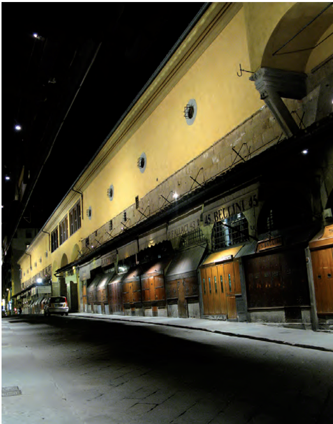
Figura 11 – Ponte Vecchio. Fronte Interno 2014.
